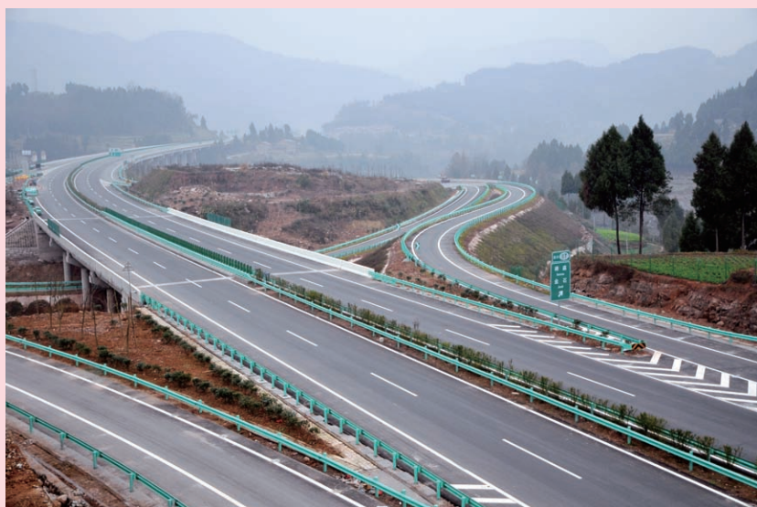
2013年12月28日,巴(中)达(州)高速公路竣工通车
