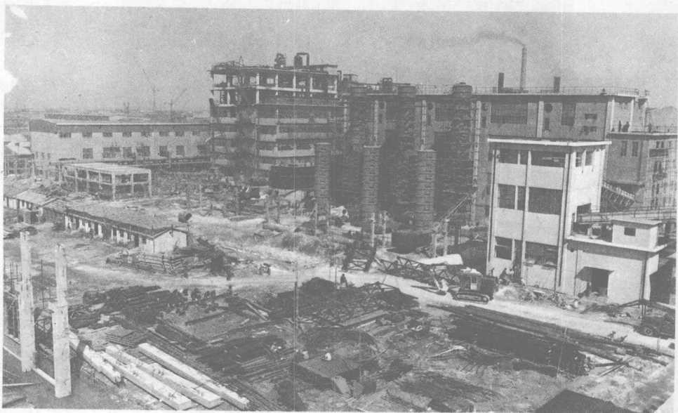
新增年产15万吨纯碱扩建工程正在施工
