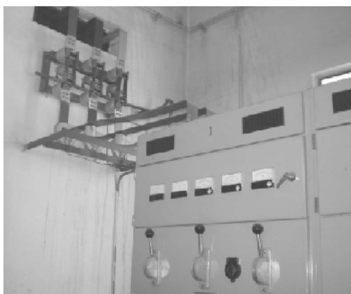
图 1-21 变压器二次开关与低压盘的连接（盘前看）
