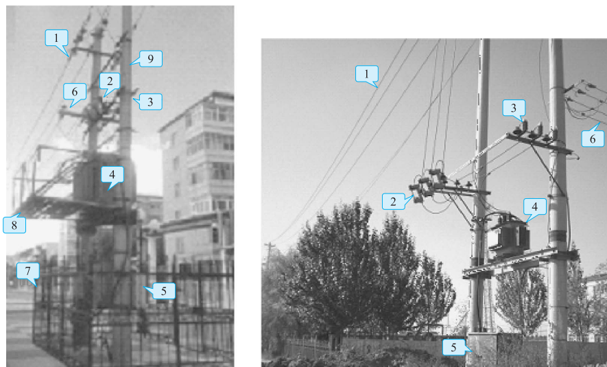
图 1-1 柱上变压器
