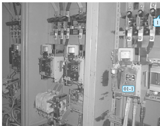
图 1-31 采用隔离开关与低压断路器馈出
