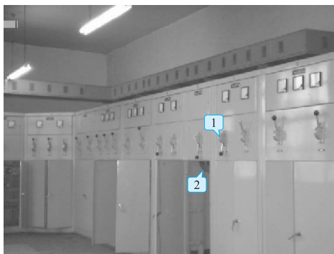
图 1-28 变电站的母联（盘前看） 1—操作把手；2—传动机构
