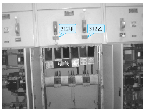
图 1-25 变电站低压母联隔离开关 操作把手和编号
