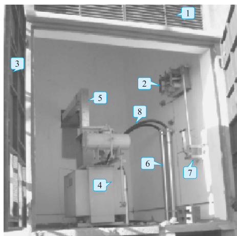
图 1-18 室内变压器一次可与墙上的开关的连接 1—百叶窗；2—变压器一次隔离开关；3—门；4—变压器； 5—变压器二次母线；6—电缆保护管； 7—变压器一次隔离操作把手；8—一次电缆
