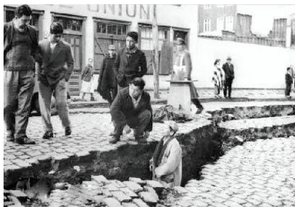
大地震中出现的裂缝
