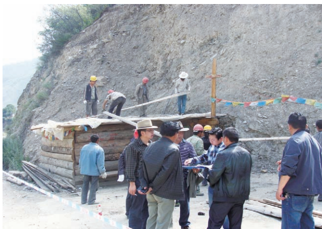
依法拆除违规搭建构筑物
