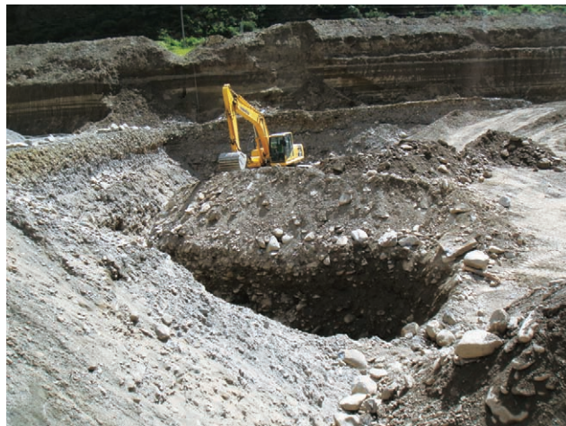
幸福工程（通村公路建设）
