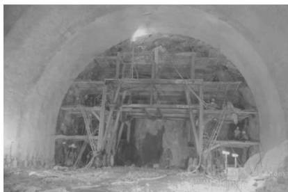
图1-5 隧道开挖支护
