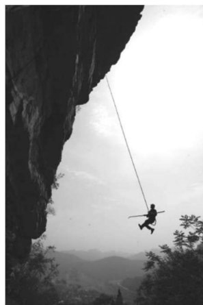
图 1-10 悬崖峭壁上的施工
