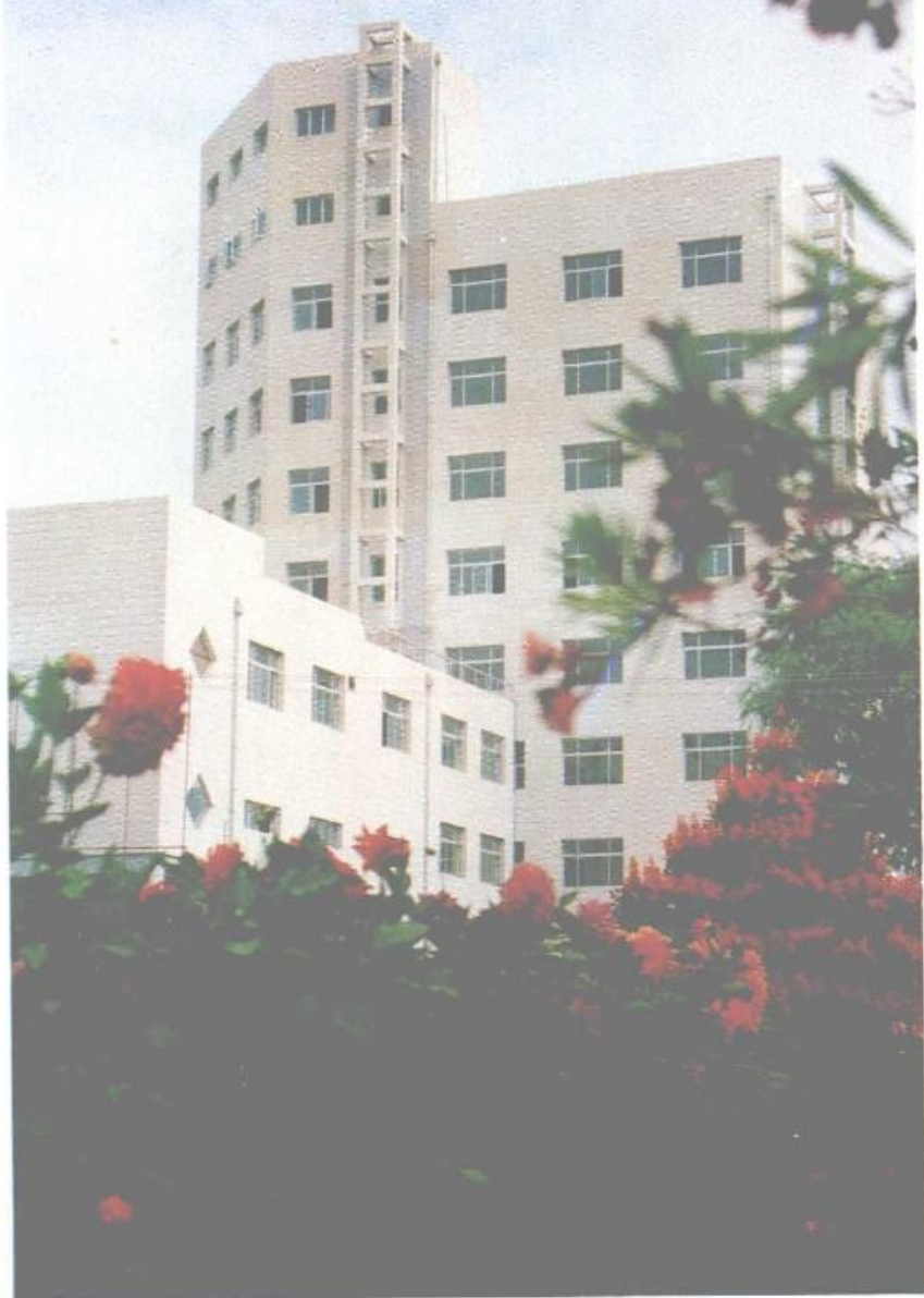
图为现已使用的连城铝厂新办公楼
