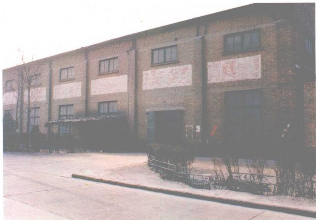
图为旧机修厂房外景
