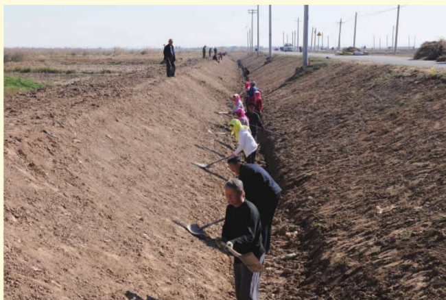
高效节水灌溉蓄水池施工
