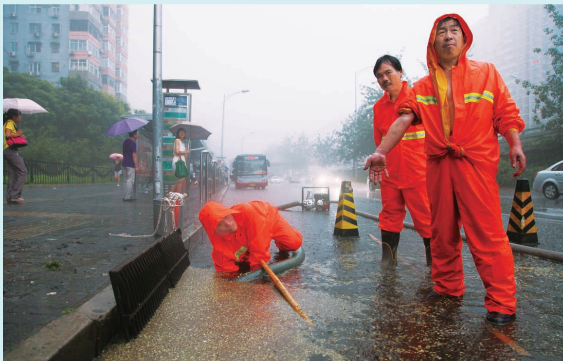
●2012年7月,北京市排水集团雨中抢险,积极应对“7·21”暴雨造成的城市内涝
