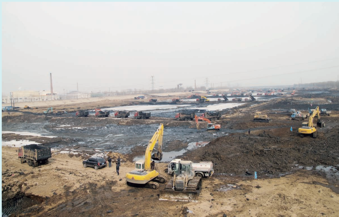
● 2012年2月,总投资27.9亿元的天津永定新河综合治理工程全面展开,图为施工现场 (天津市水务局 供稿)
