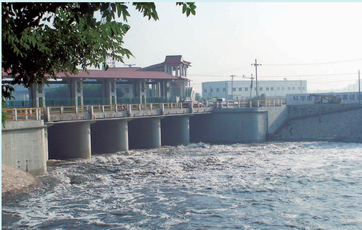
●2012年7月,为应对“7·21”暴雨,屈家店枢纽北运河节制闸十年来首次开闸泄洪 (卢科 摄)
