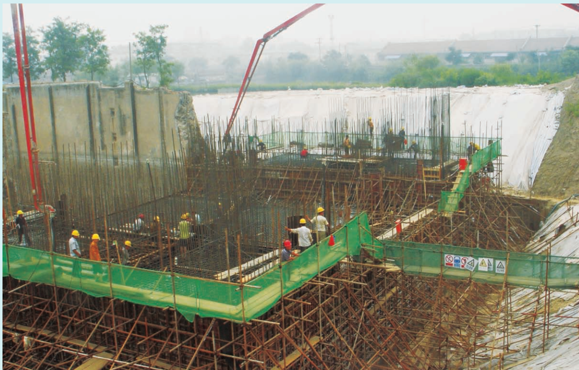
● 2012年4月,大清河下游西河右堤(西河闸段)防洪堤防除险加固工程开工建设,图为建设现场 (海河下游局 供稿)
