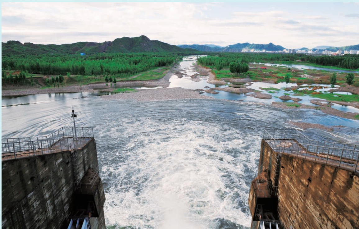
●2012年7月,为应对滦河洪水,大黑汀水库表孔闸提闸泄洪
