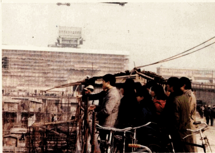
工测系学生在葛洲坝工地参观
