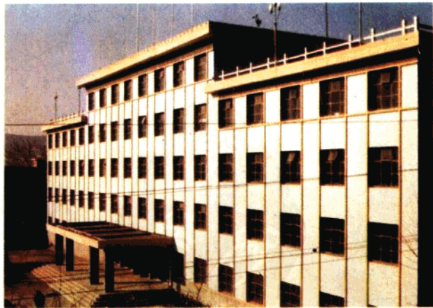
中共临洮县委办公楼
