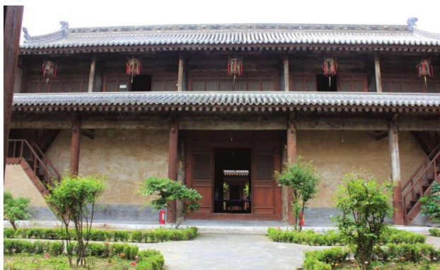
天水市秦州区北宅子过厅
