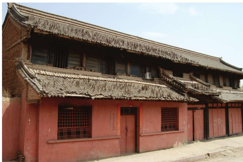
宕昌县哈达铺民居建筑
