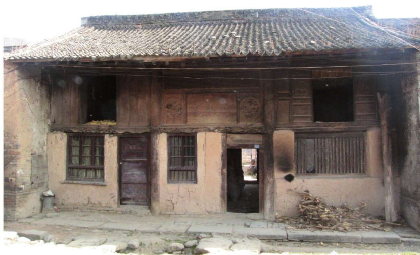
两当县杨店乡板屋式民居建筑
