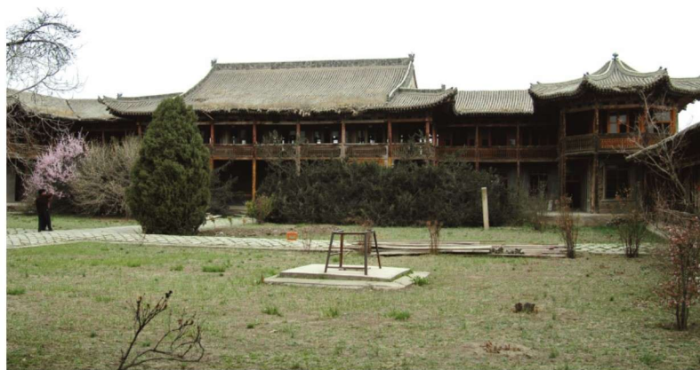
临夏市蝴蝶楼主楼
