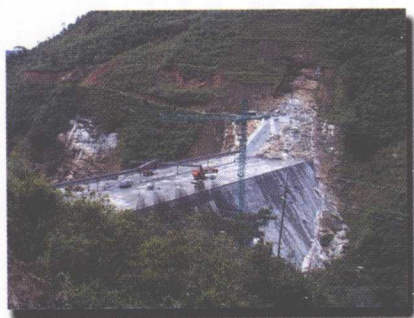
普拉塔诺弗里西，希腊 业主：公用电力公司 PPC 高度：97 米；碾压混凝土体积：420,000 立方米 现状：1998 年 9 月 17 日开始蓄水 MD&A：承担大坝主体的工程咨询
