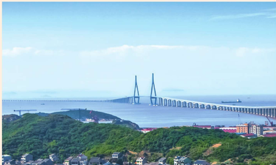
浙东经济合作区连接宁波、舟山两市的舟山大陆连岛工程金塘大桥于 2009 年 12 月 25 日正式通车
