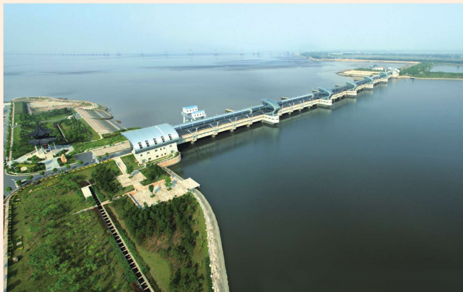
浙东引水工程曹娥江大闸航拍图
