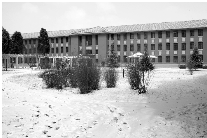
◎1954年建成的东三楼
