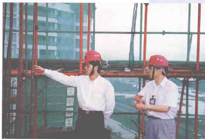
建管科在建筑工地检查
