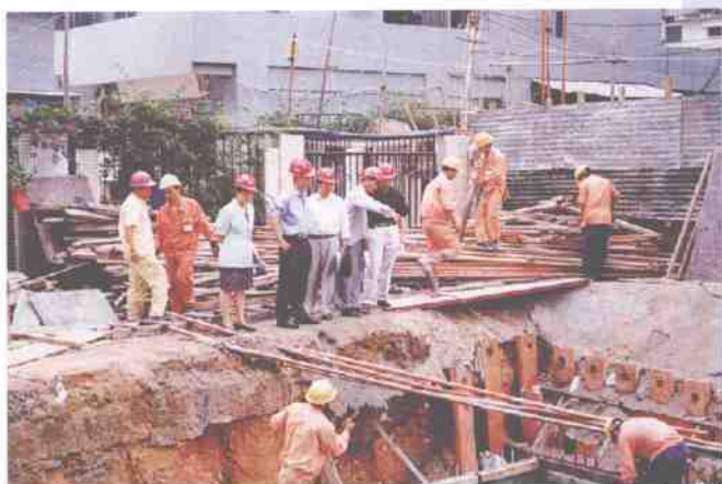
住宅开发中心工程管理人员在福田大厦工地现场
