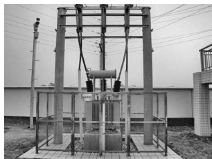
图 1-12 站(所)用 变压器 (三)
