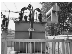
图 1-41 消弧线圈（一）
