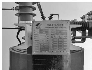
图 1-42 消弧线圈（二）
