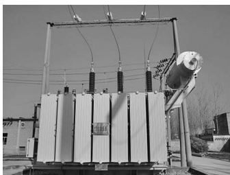
图 1-5 主变压器（五）
