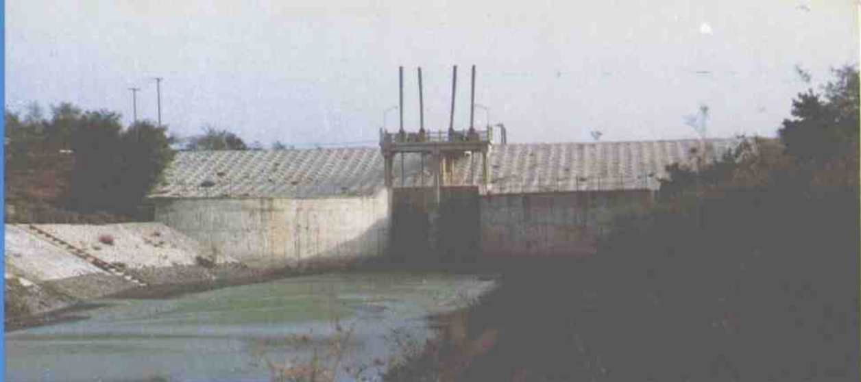
北陈海穿堤涵洞
