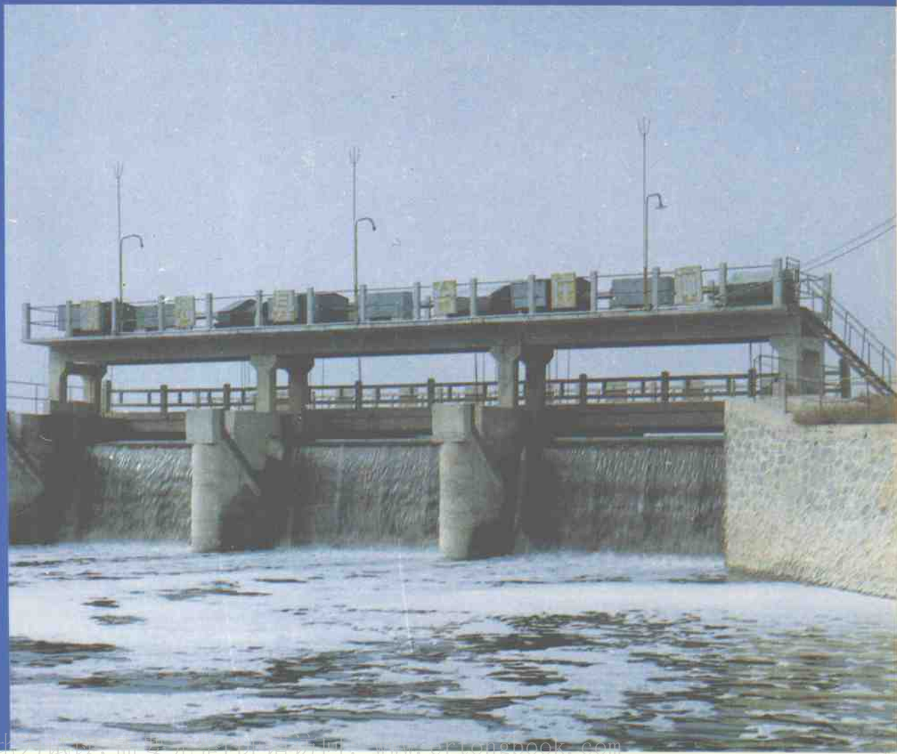
西沙河台家庄节制闸
