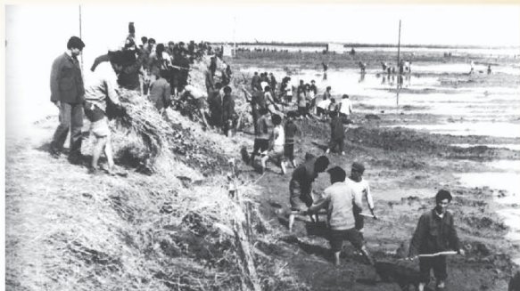
1971年11月5~10日，全区治理黄河经验交流会在中宁县召开。据统计，本县自1952年以来，累计修筑防洪堤365公里，砌草面护岸码头700多座，堵关河汉35处，修筑“丁”字堤坝151座。图为保堤抗洪施工现场。
