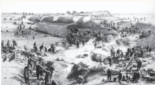
1958年4月，跃进渠开挖工程开始施工，8月全线通水。参加施工的有中宁县的社员、干部、学生共计14391人，中卫、宁朔、永宁和银川的支援民工8768人。图为开挖施工现场。
