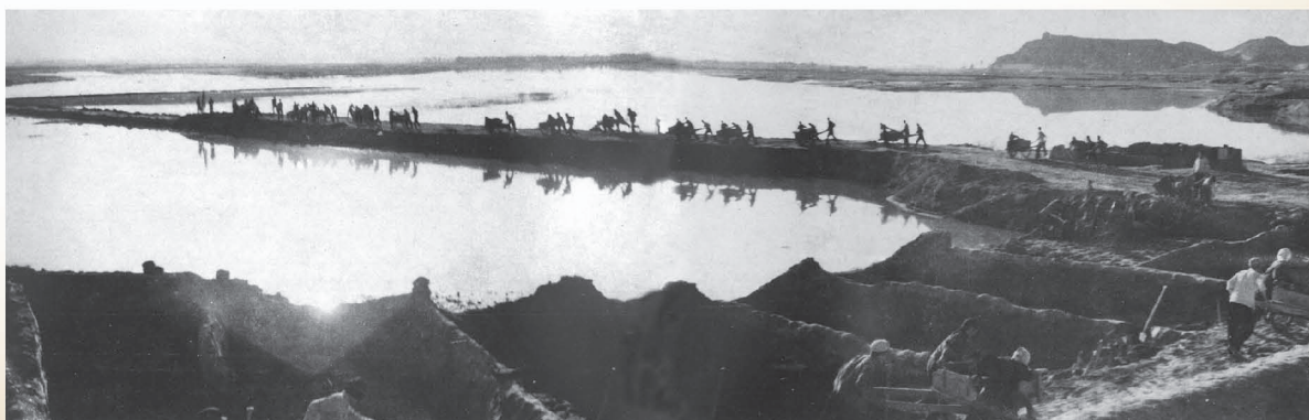
20世纪70年代，胜金关黄河护岸工程施工现场。
