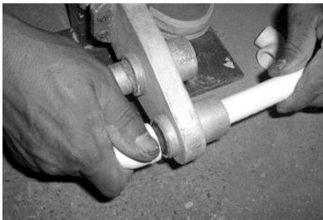
图 1-6 热熔连接
