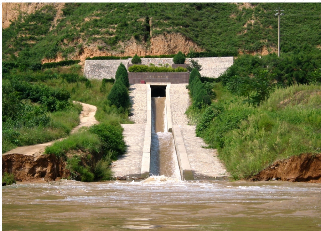
羊毛湾水库引冯济羊工程输水洞
