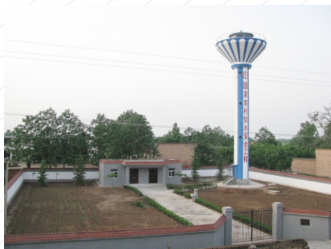
渭城区北杜镇靳里村农村人饮工程
