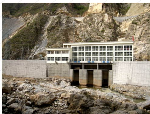
建设中的文泾水电站主厂房
