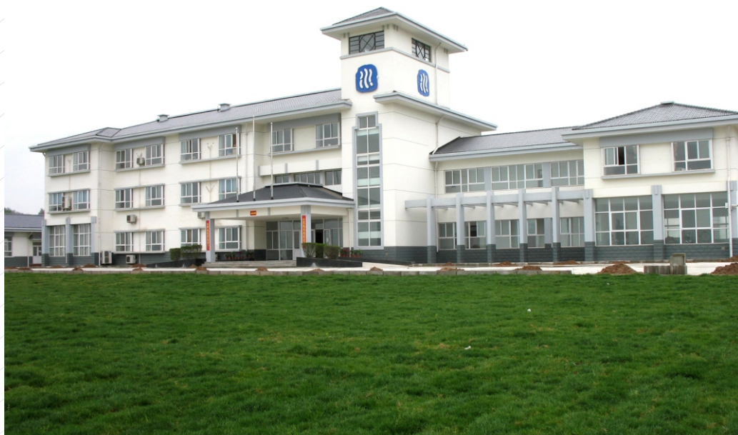
招商引资之中环公司净水厂综合办公楼
