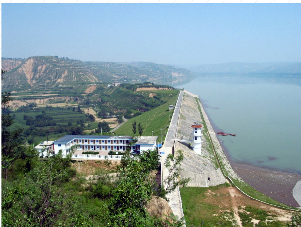
除险加固后的羊毛湾水库
