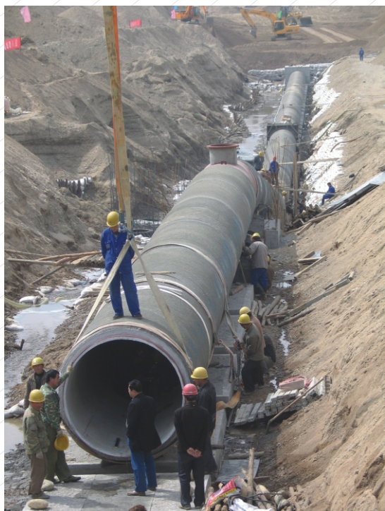
引石过渭工程管道安装施工现场
