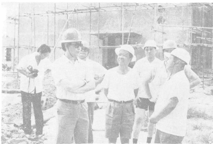
河南省副省长刘源来孟视察火电厂工程建设情况。
