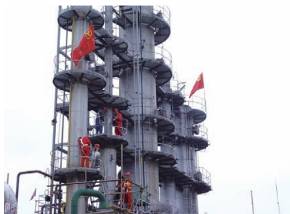
青年突击队检查吸收塔
