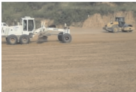
图 1.31 灰土路堤施工
