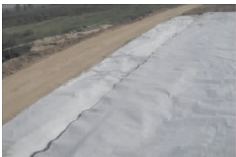
图 1.34 灰土路基覆盖养生
