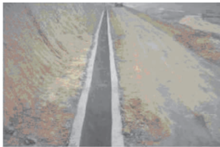
图 1.25 路堤临时排水
