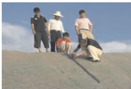
图 1.46 坡率度检查
