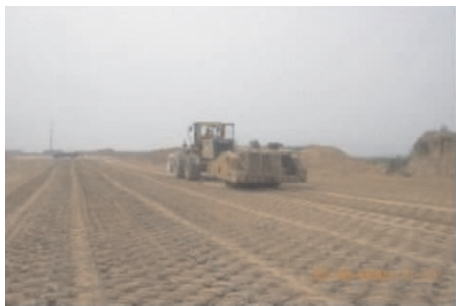
图 1.20 拖式羊足碾施工
