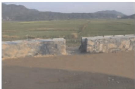
图 1.22 路基临时排水
