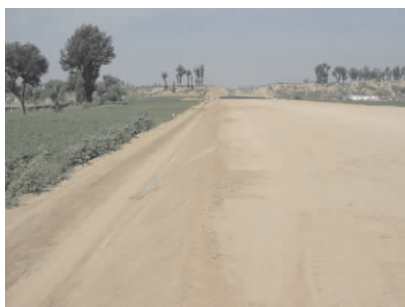
图 1.35 灰土边坡整形
