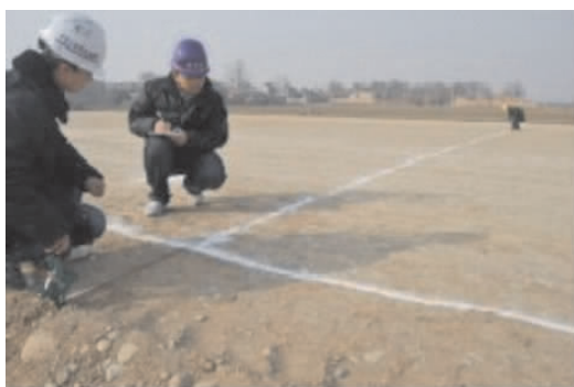
图 1.44 路基宽度检测
