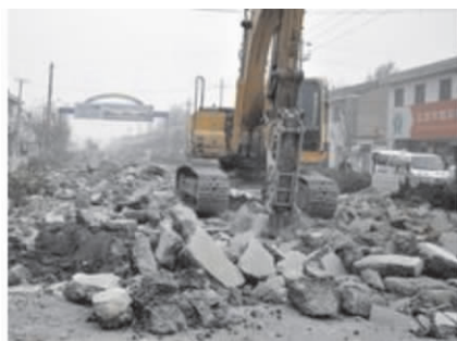
图 1.12 破除旧路面
