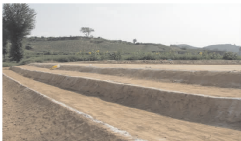
图 1.26 填方台阶施工
