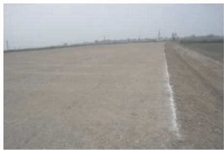
图 1.33 边坡线形顺直
