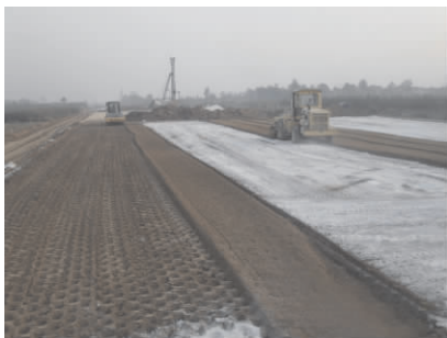
图 1.30 灰土路拌法施工
