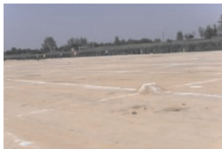
图 1.17 控制墩控制松铺厚度
