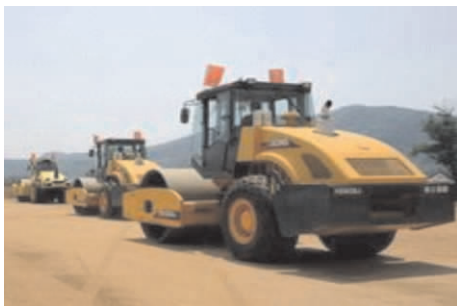
图 1.21 光轮压路机施工
