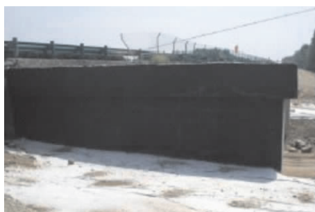
图 1.53 台背回填覆盖养生
