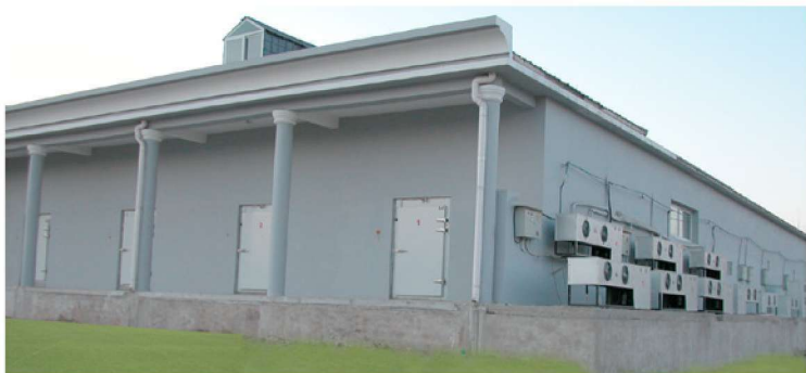
土建装配复合式多单元 1 000 吨自动冷库群 (10 ~ 100 吨多冷间组合)
