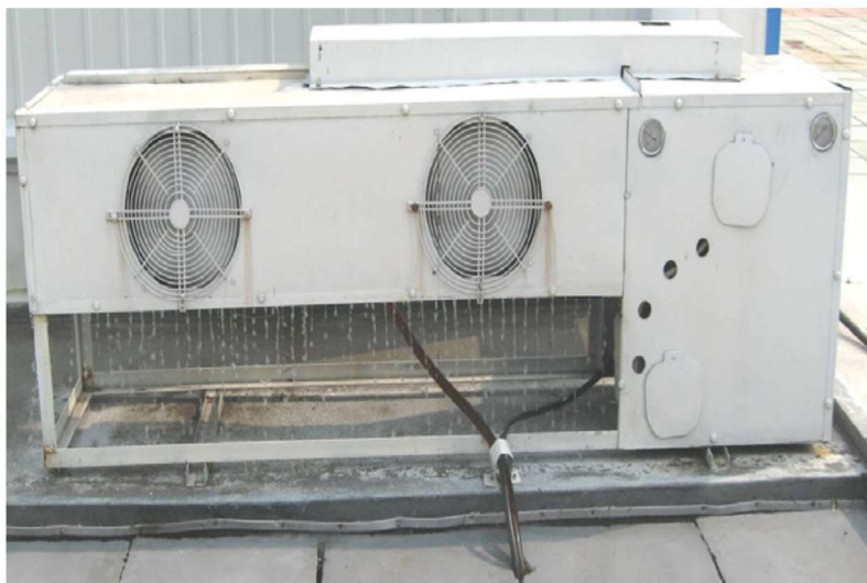
多效冷凝 3 ~ 5 kW 机组 (10 ~ 20 吨库用)
