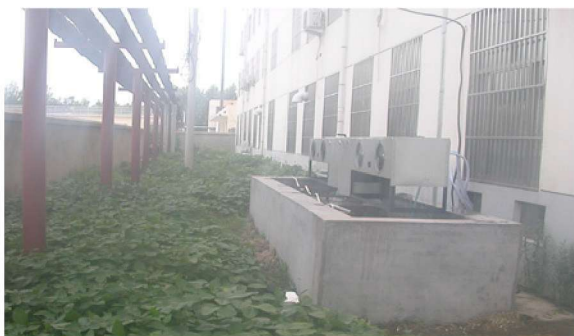
10 吨、20 吨联建自动冷库 (办公楼地下室改建)
