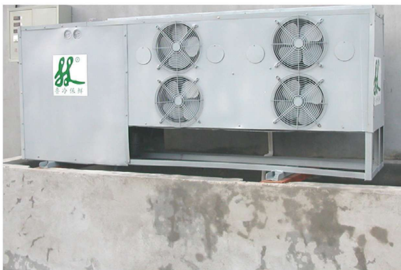
多效冷凝 10 ~ 15 kW 机组 (50 ~ 100 吨库用)
