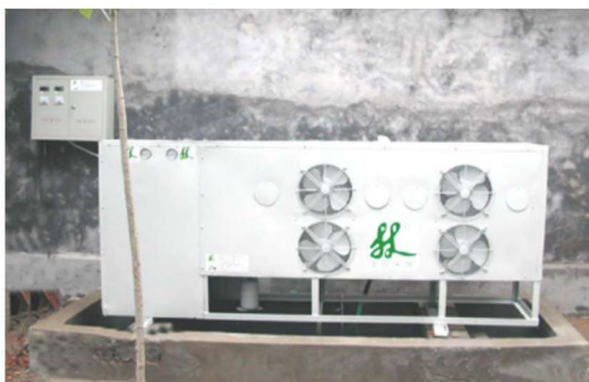
土建装配复合式 100 吨自动冷库 (多效冷凝制冷机组半地下储水池式)
