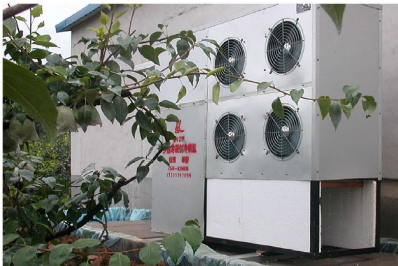
50 吨预冷保鲜多功能自动冷库（果园内土建装配复合式）
