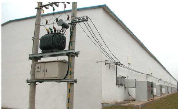
土建装配复合式多单元 2 000 吨自动冷库群 (200 吨多冷间组合)
