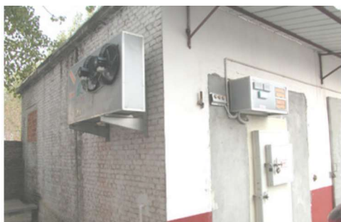
土建装配复合式挂机自动冷库 (车库改建 10 吨库)
