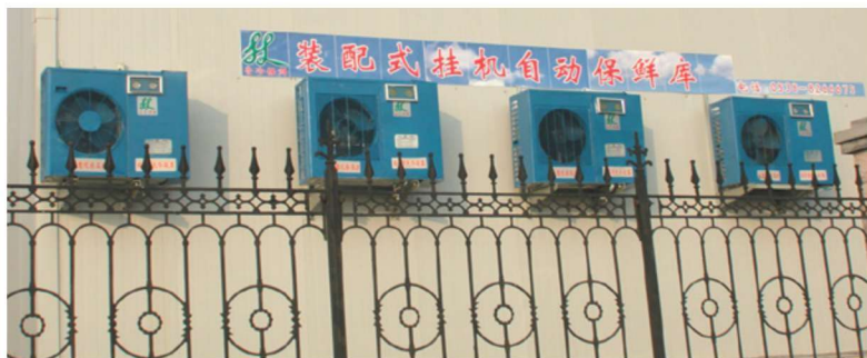
装配式多挂机自动冷库（10 吨单元）
