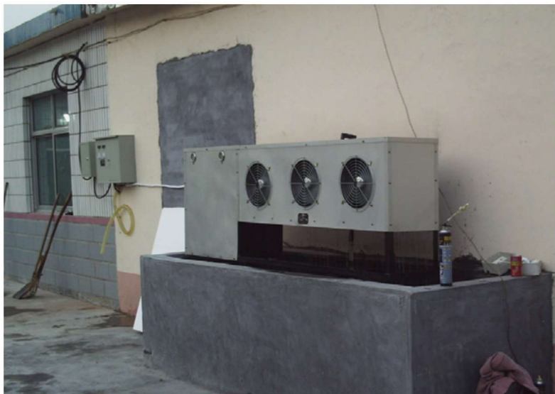
土建装配复合式 50 吨自动冷库（旧仓库改建地上式水池）
