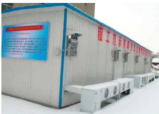
装配式 10 吨多单元自动冷库群 (多效冷凝制冷机组地下储水池式)
