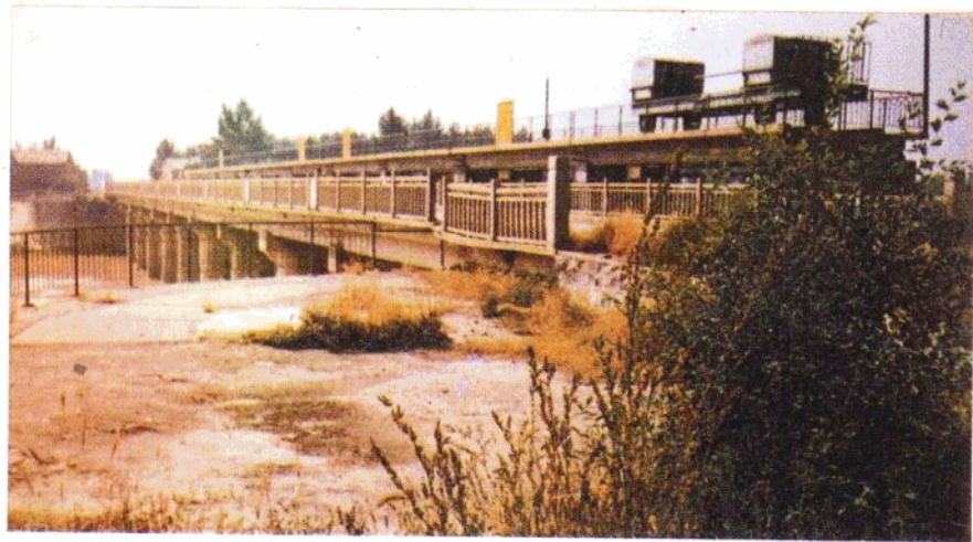
安新县同口唐河大 桥南端闸桥
