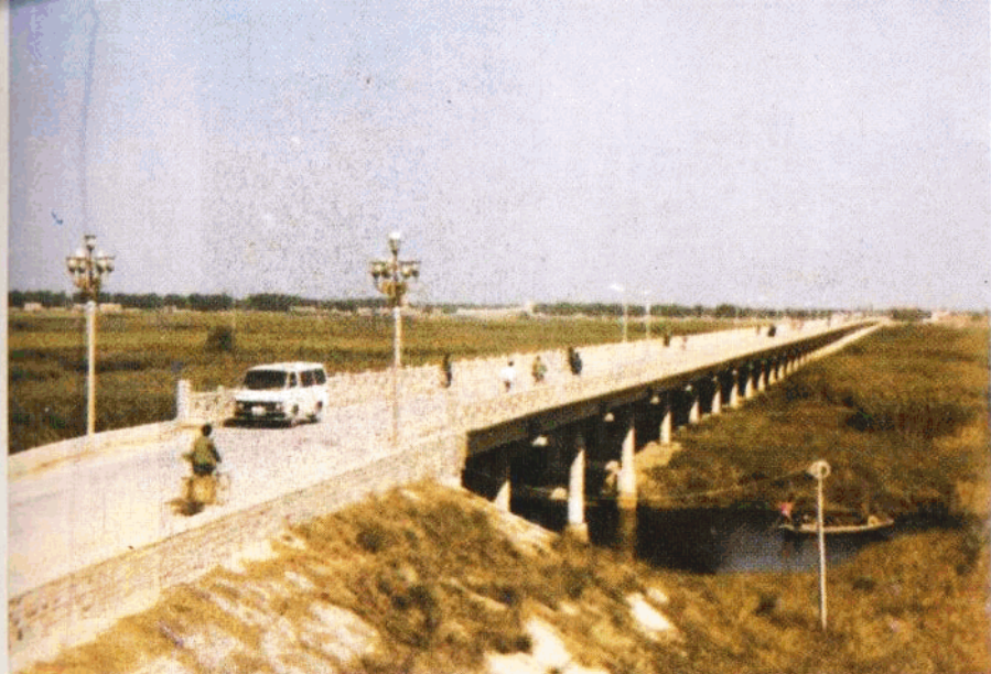
全长一一八四，四八米 安新县白洋淀大桥
