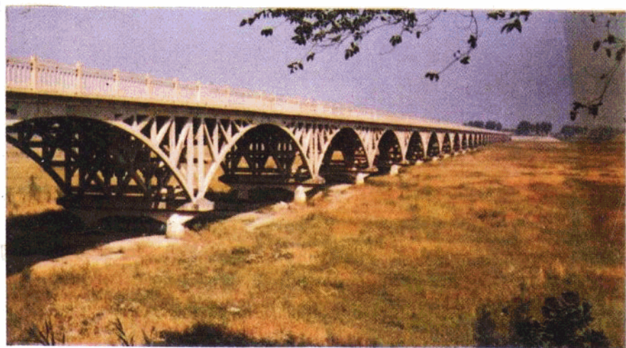
唐河大桥中间公路桥
