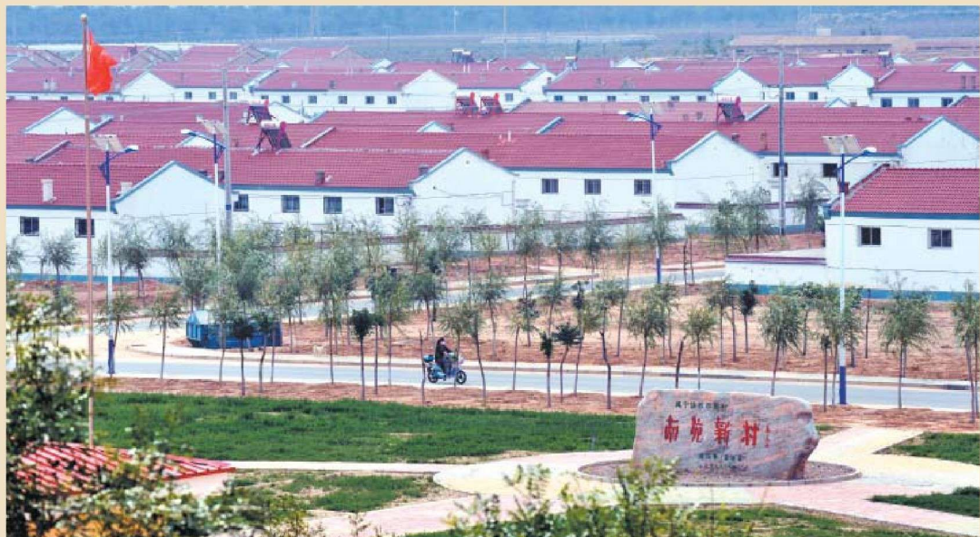
◎ 生态移民工程
