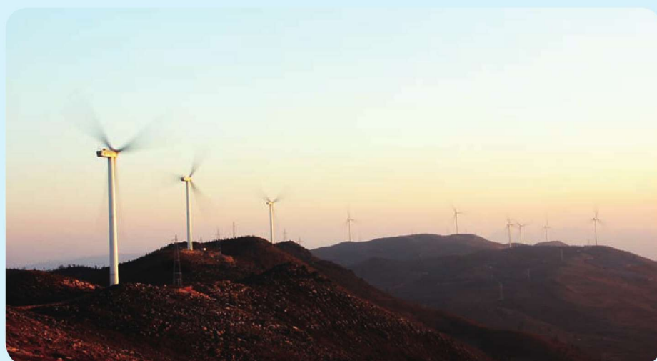
朵古(莲花山)风力发电机组一角
