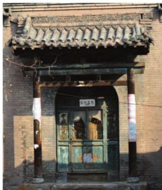
槐树院闷房门楼
