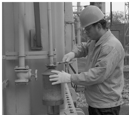
图 1-12 工作人员在进行呼吸器维护
