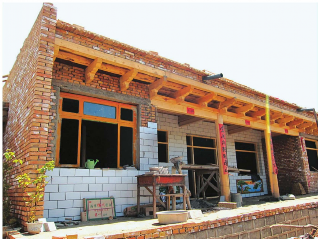
局部木柱外廊式的砖木结构房屋
