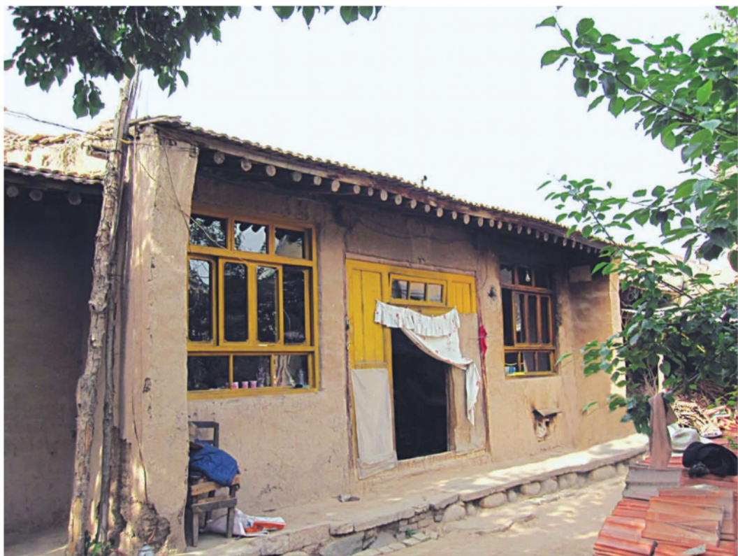
土木结构房屋
