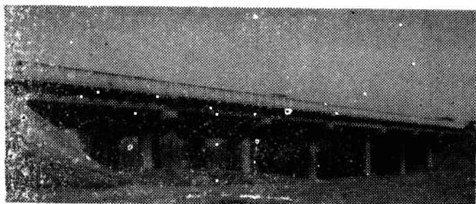
沧（州）石（家庄）公路光明桥（大件运输）
