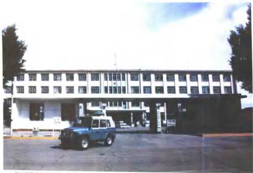
锡林郭勒盟行政公署办公楼
