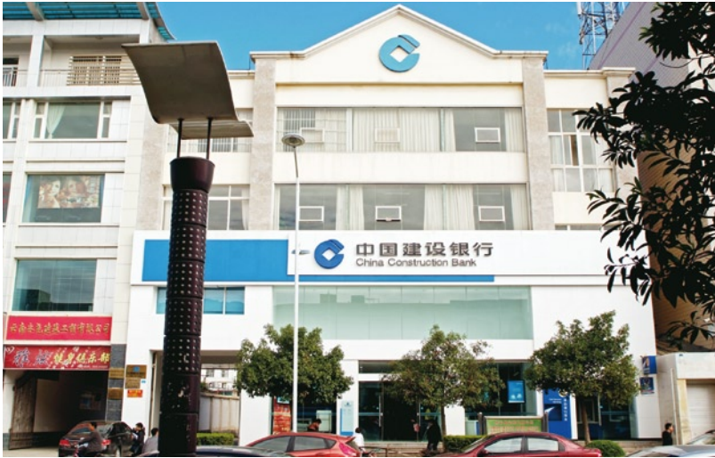
中国建设银行股份有限公司祥云支行办公楼
