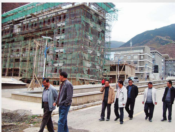
2011年10月20日,迪庆州州委常委、政法委书记李灿光(左一)在县长扎西顿珠(左二)等领导陪同下视察法庭建设工地
