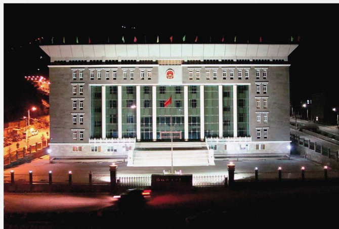
2012年新建成的法院审判大楼夜景
