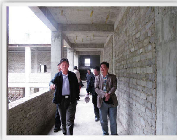
2011年8月24日,县委书记和忠华(左)到法院视察审判法庭建设工地
