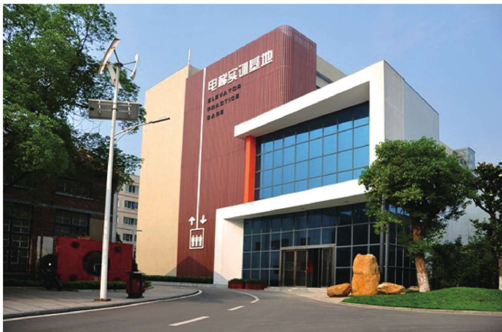
机械系电梯实训基地
