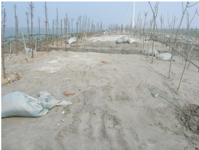
环杭州湾防护林建设工程种植施工
