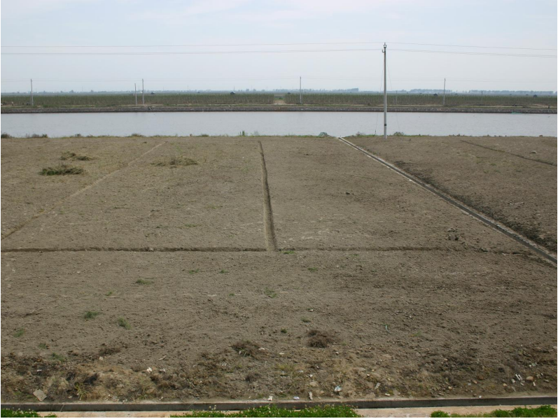
2005 年慈溪市沿海防护林工程(十塘江北侧,施工时)
