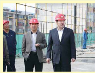
榆中县县长徐大武、副县长蔡泽雄 检查校安工程建设情况(2009)
