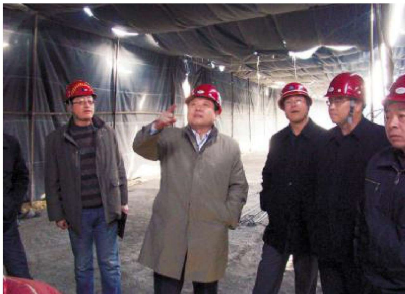
2月16日,水利厅副巡视员陈广宏(左二)在惠农渠永一涵洞改造工程现场检查工作
