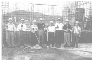
1996年10月25日，美术馆主体工程封顶仪式。
