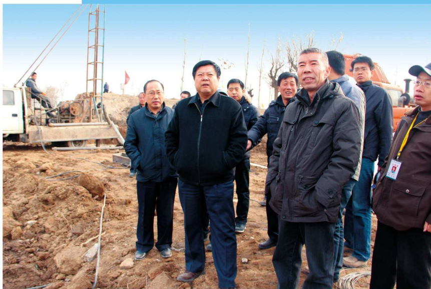
2月14日，水利厅副巡视员陈广宏(左二)在西干渠管理处工程建设工地调研
