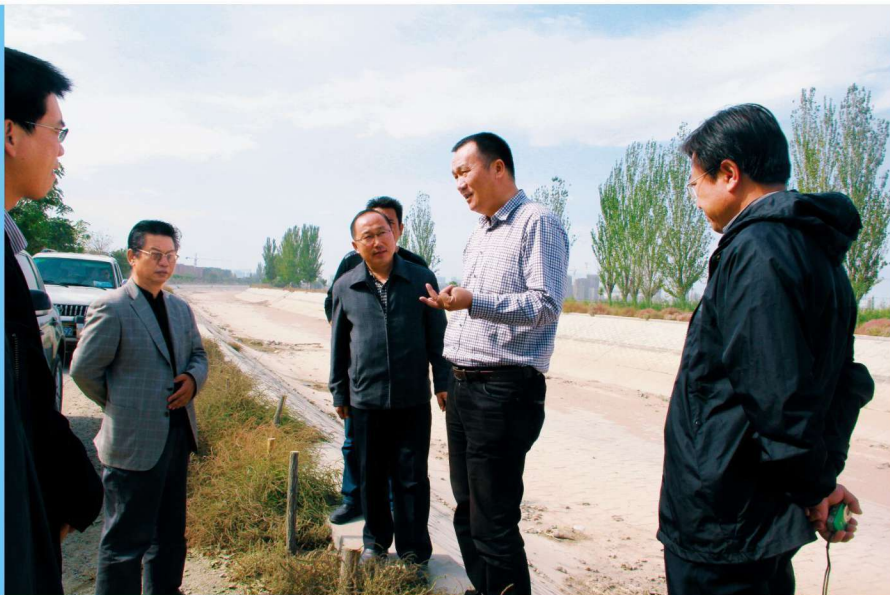
10月11日,水利厅总工程师薛塞光(右二)在唐徕渠管理处检查工程建设情况
