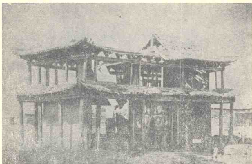
图4 同上,固原前提督署赏门震后塌坏。
