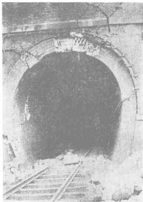
图 22 同上,内埔庄第 8 号隧道北口破坏情况。
