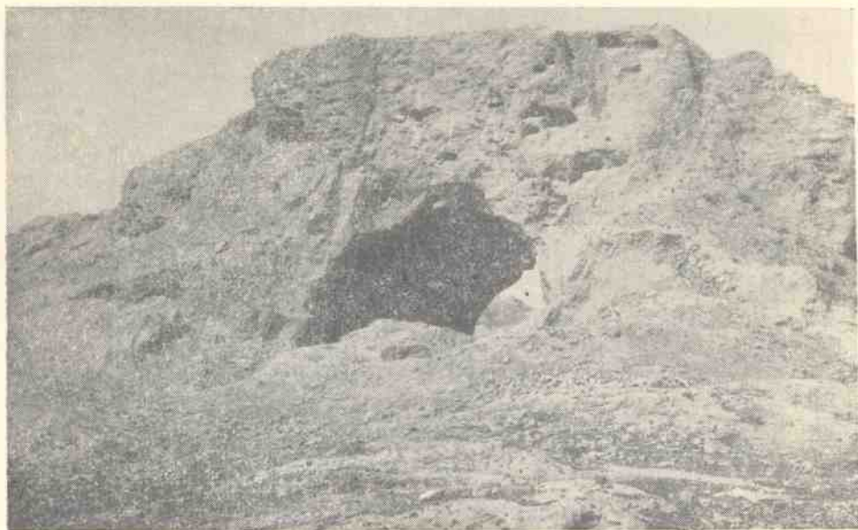
图5 同前,干盐池城楼倒塌遗迹。
