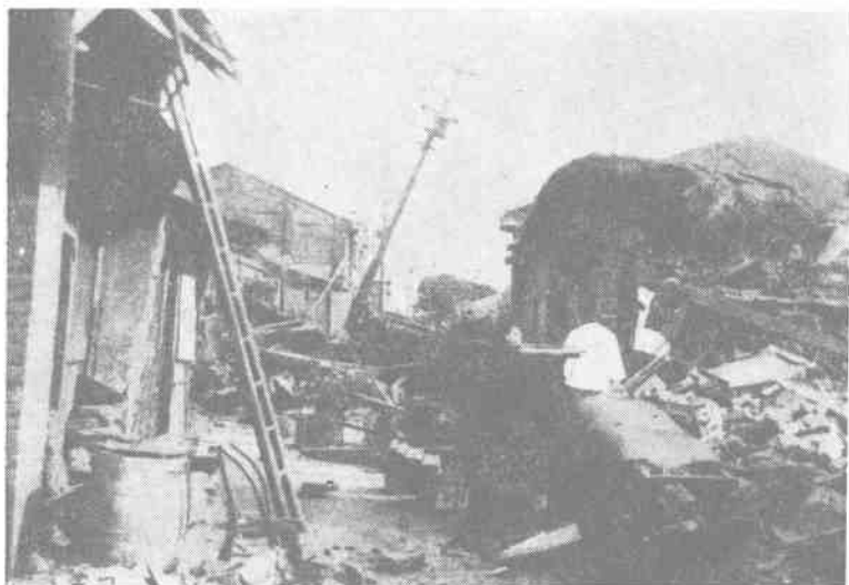
图 15 同前,公馆庄公馆震后破坏情况。
