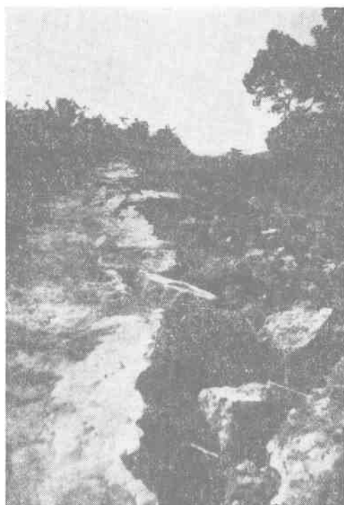
图8 同上,公馆庄棉子埔崖崩塌。
