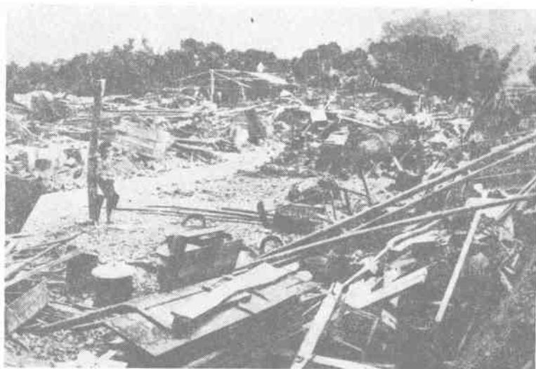
图 16 同上,土墙房屋皆倒塌,后面一木造房屋,木架未倒。
