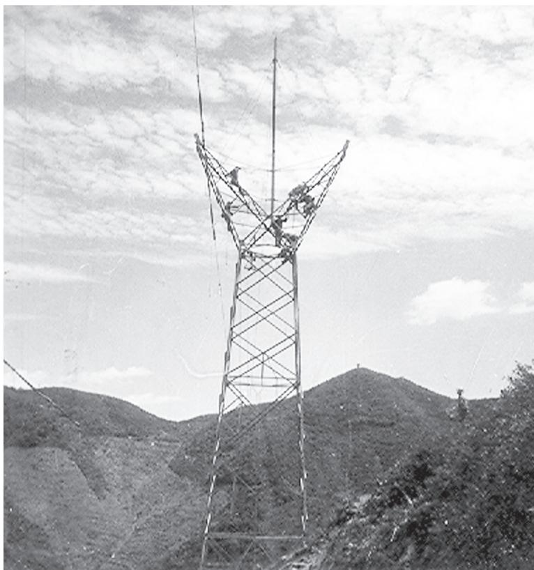
图为上世纪70年代,110千伏穿山变进线铁塔架设施工场景
