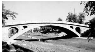
图1.6 石材结构的赵州桥
