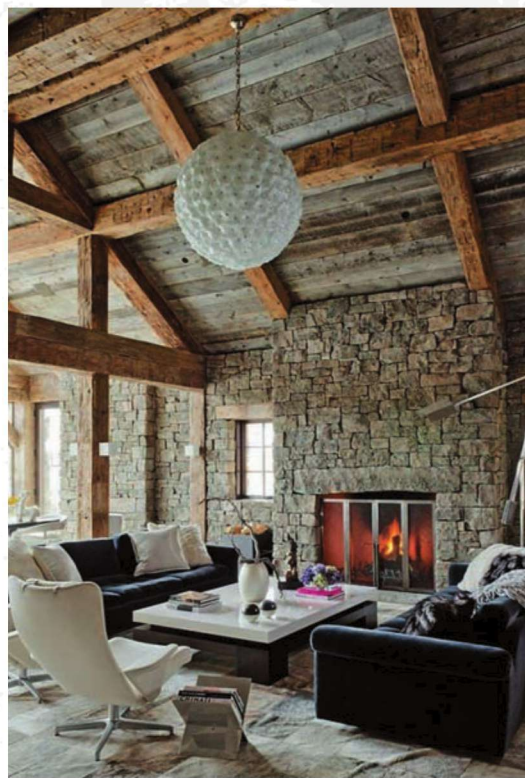
图3-55 承重墙与木梁
