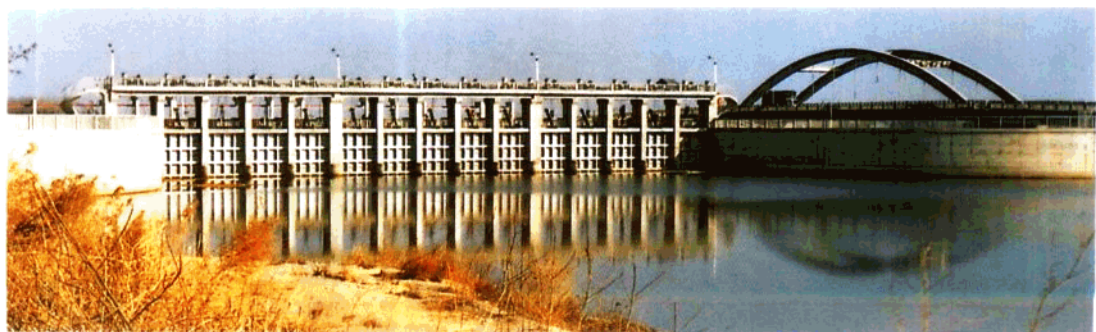
苏北灌溉总渠通榆河地涵工程
