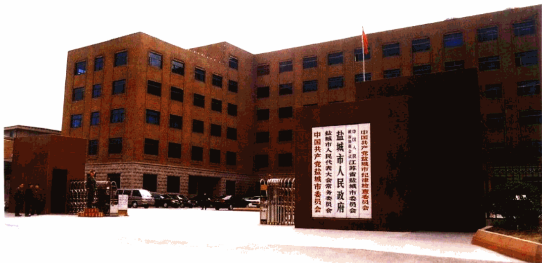
盐城市领导机关办公楼
