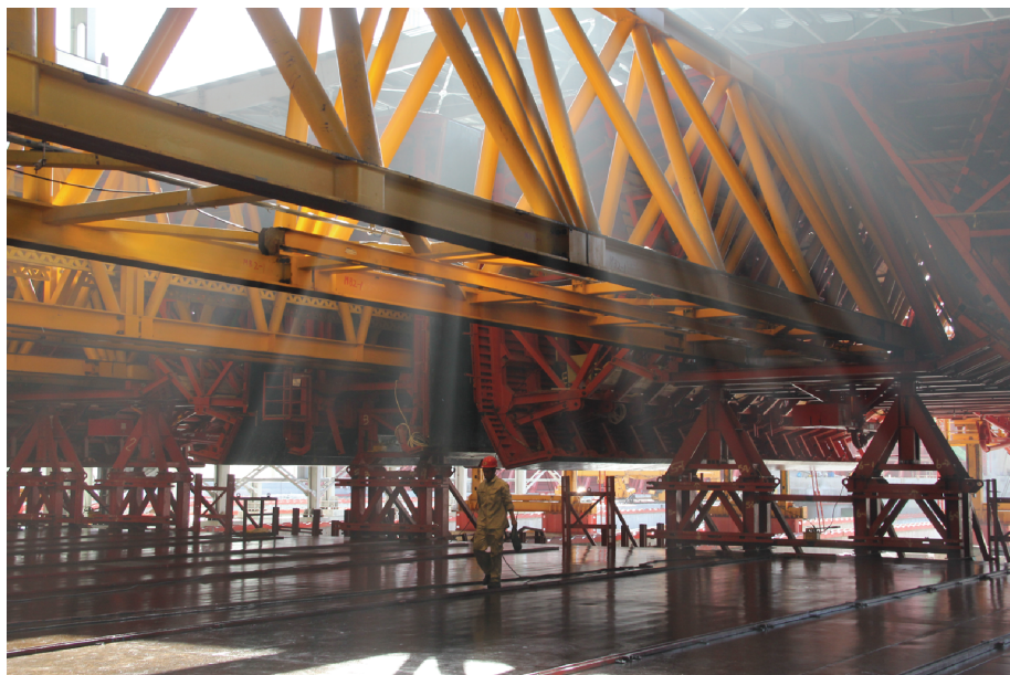
沉管预制厂钢模板系统
