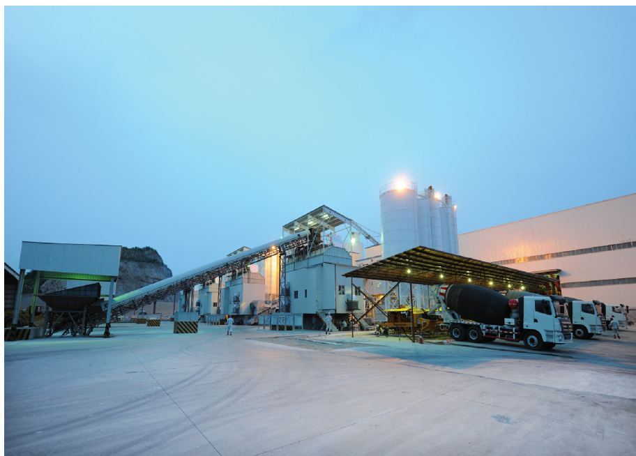
沉管预制厂搅拌站
