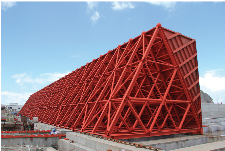
沉管预制厂浅坞钢闸门
