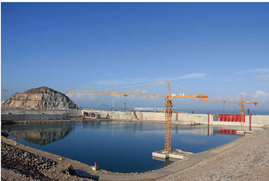
沉管预制厂深坞
