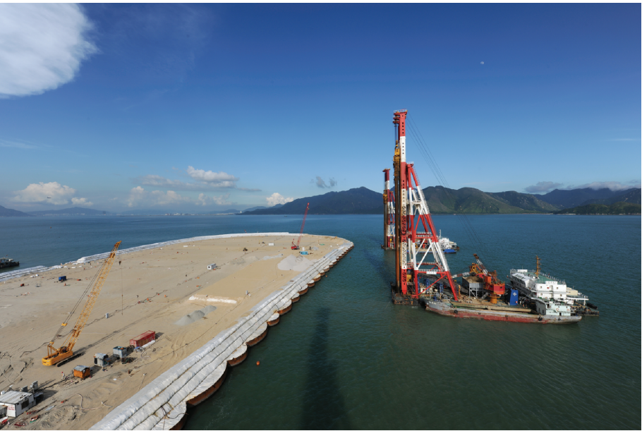
东人工岛挤密砂桩施工
