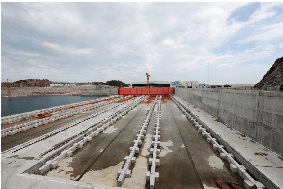
沉管预制厂浅坞区
