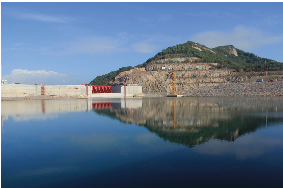
沉管预制厂深坞
