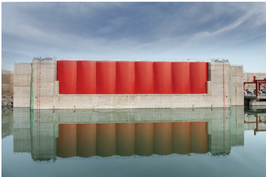
沉管预制厂深坞坞门
