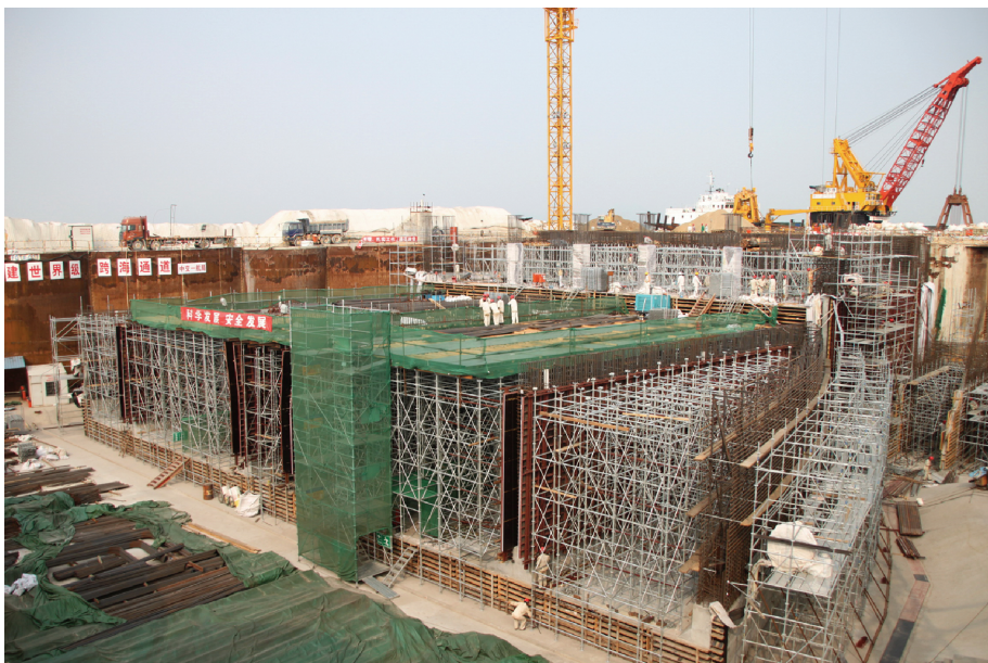
西人工岛暗埋段结构施工
