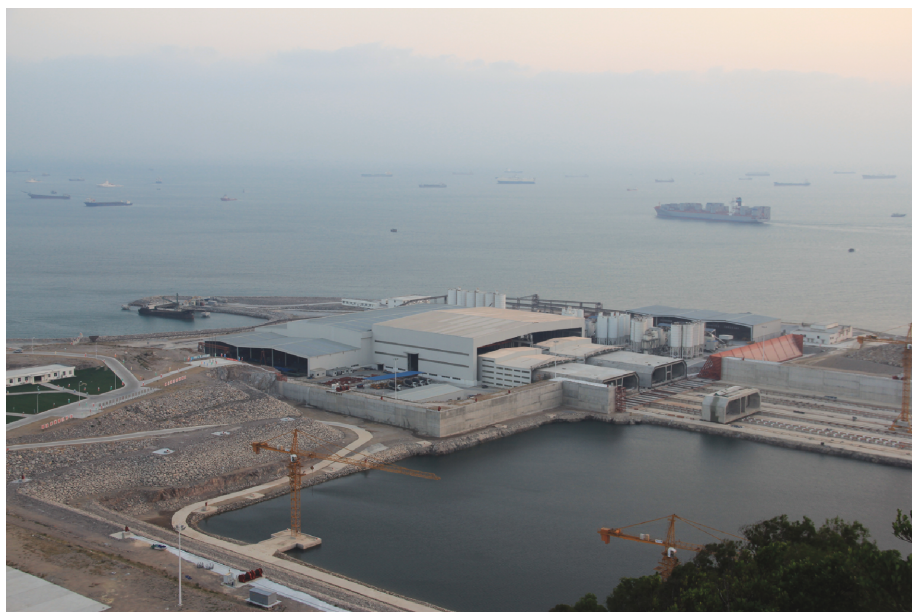
沉管预制厂全景
