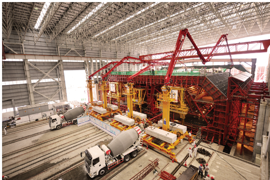
沉管管节浇筑
