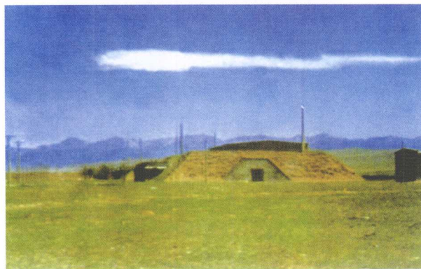
二二一厂第二生产部半掩体生产车间
