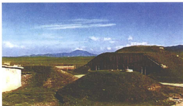
二二一厂六厂区爆轰试验场之一
