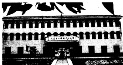
北流市六建镇中心小学教学楼。
