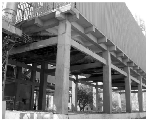
图 1-2 全混凝土结构体系
